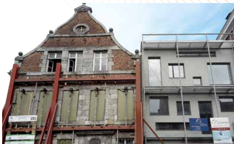
Links sieht man das alte Gebäude aus dem Jahr 1697. Noch sind die schweren Stützpfeiler nötig, um einen Einsturz zu verhindern. Rechts im krassen Gegensatz der ultramoderne Neubau.
