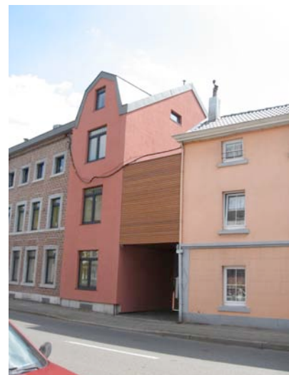
Energetisch sanierte Fassade, Schilsweg 17.
