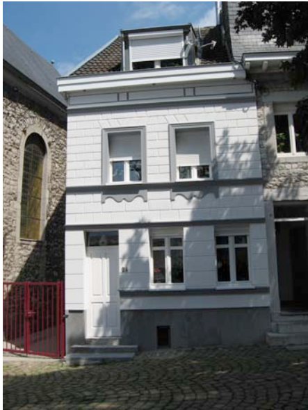
Werthplatz: Beispiel einer gelungenen äußeren Fassadendämmung, unter Beibehaltung des ursprünglichen Charakters.
