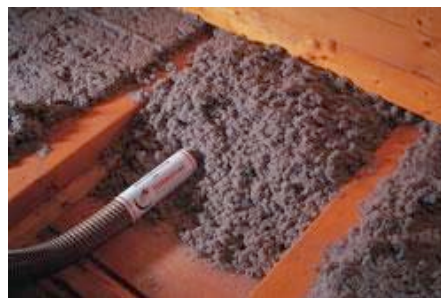
Kostengünstigste Art, nicht ausgebaute Dächer zu dämmen: durch Verfüllen der obersten Geschossdecke mit Zellulose.
